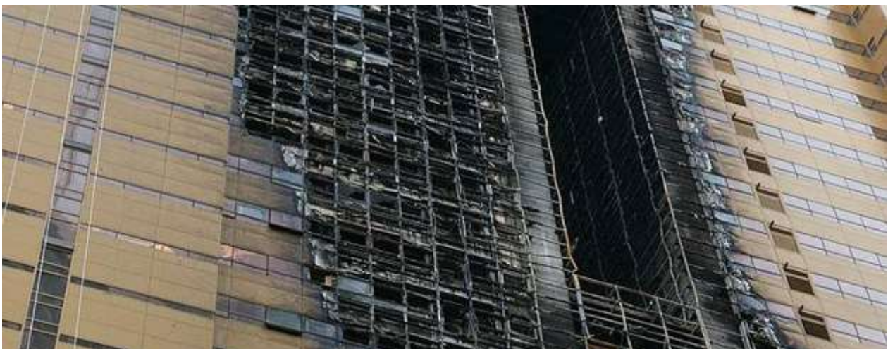
DIFFUSIONE DELL'INCENDIO ALL'INTERNO DI CAVITÀ VERTICALE INTERNA
