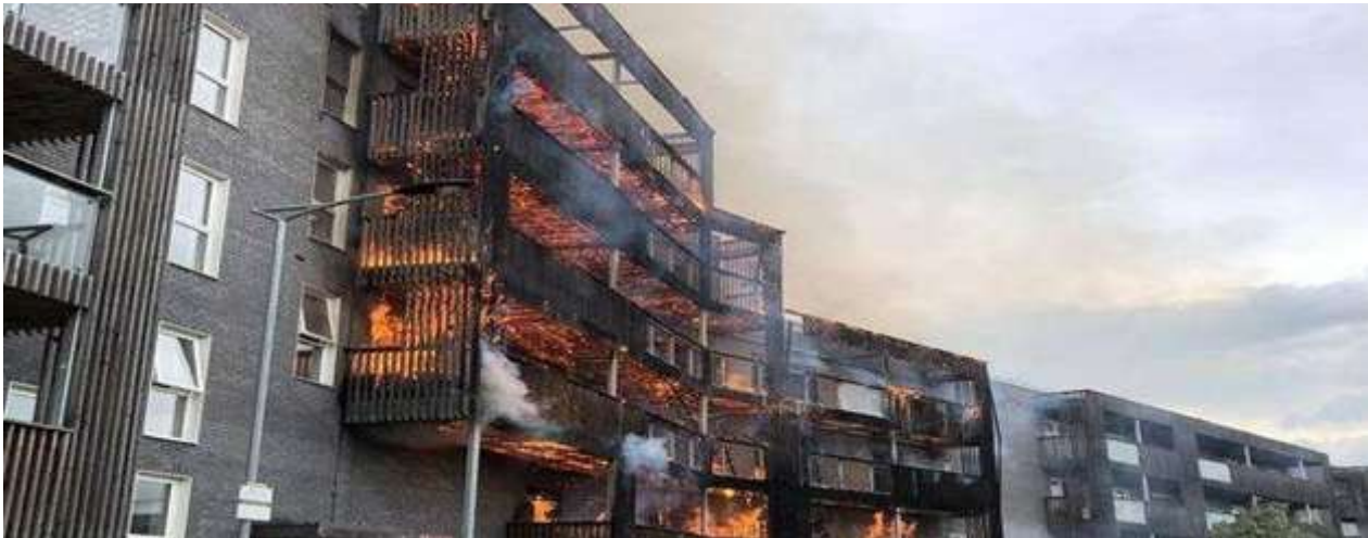
DIFFUSIONE DELL'INCENDIO TRAMITE BALCONI ESTERNI
