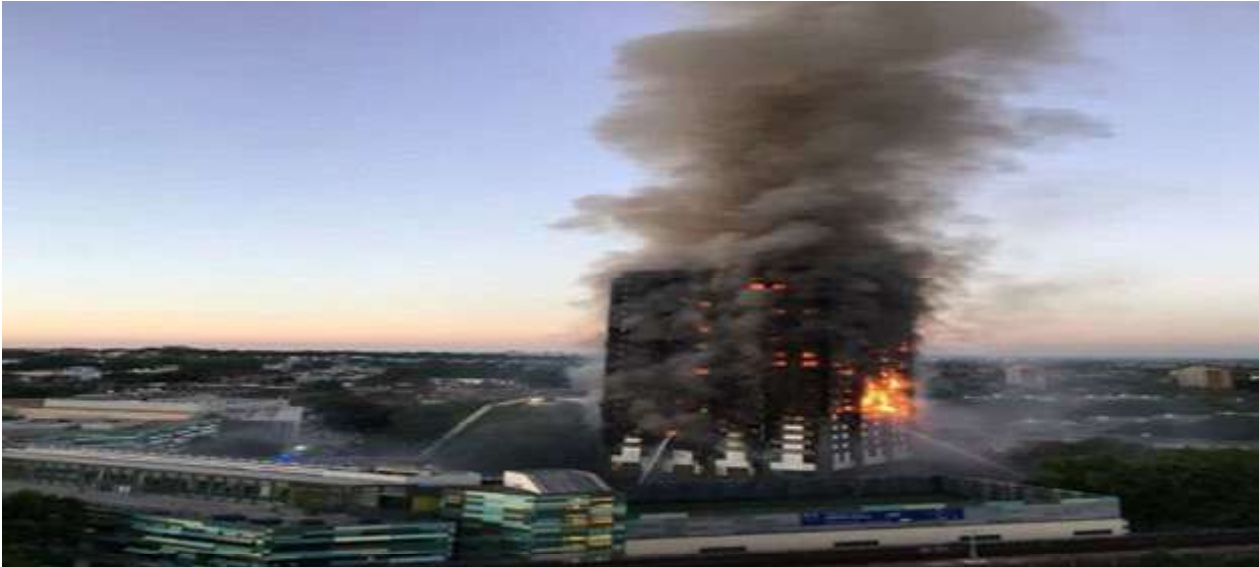
DIFFUSIONE DELL'INCENDIO PROVOCATA DALLA DEGRADAZIONE DELLA PELLE ESTERNA NON COMBUSTIBILE
