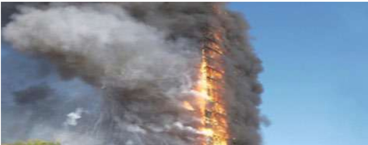
DIFFUSIONE DELL'INCENDIO SULLA SUPERFICIE ESTERNA DELLA PARETE
