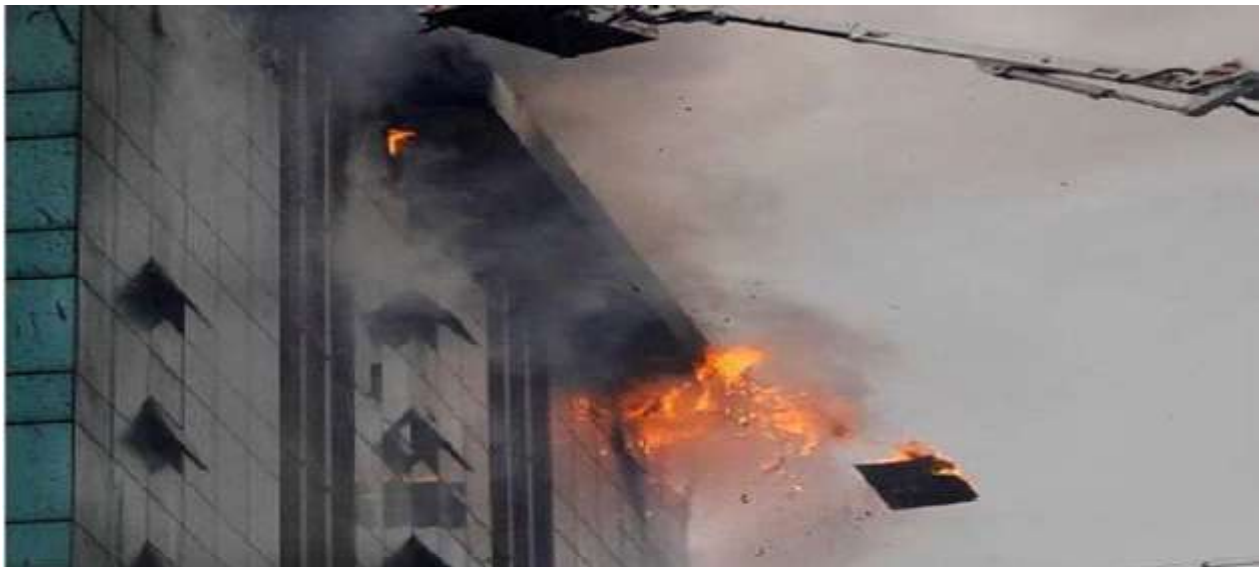
DIFFUSIONE DELL'INCENDIO PROVOCATA DALLA CADUTA DI DETRITI IN FIAMME AI PIANI INFERIORI
