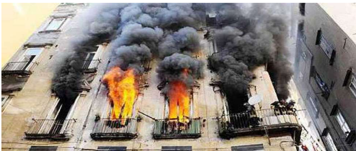
PROPAGAZIONE DELL'INCENDIO SULLA FACCIATA
