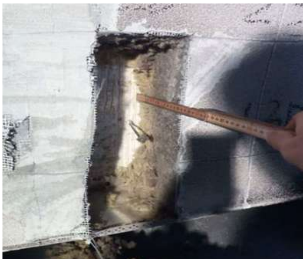
TEST - SISTEMI ETICS CON ISOLANTI INCOMBUSTIBILI
