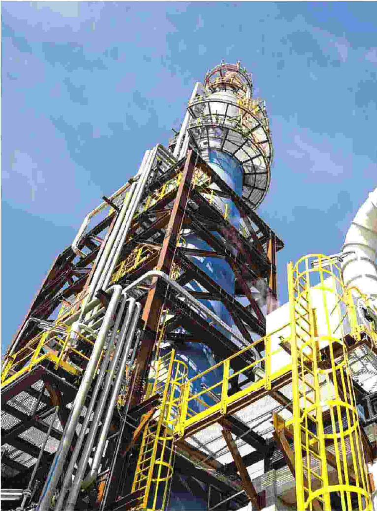
Infrastrutture. L'impianto Eni di Casalborsetti al centro del progetto Ravenna Ccs
