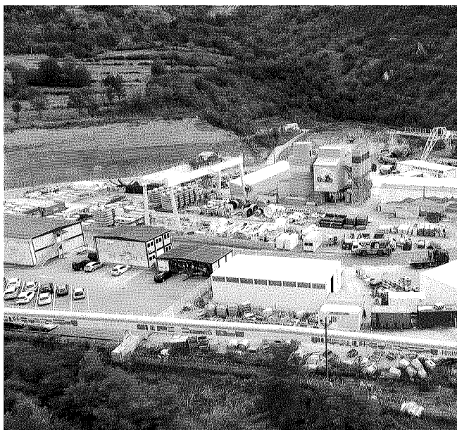
Il cantiere della Tav
