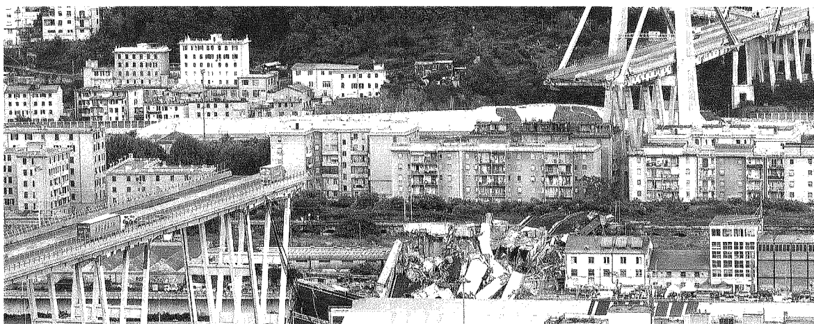
Spezzato Una sezione del Ponte Morandi, nel tratto finale dell'autostrada A10, dopo il crollo del 14 agosto 2018
