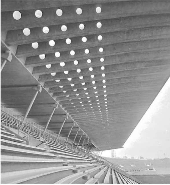
Una foto d'archivio realizzata subito dopo la realizzazione dell'impianto per le Olimpiadi del '60
