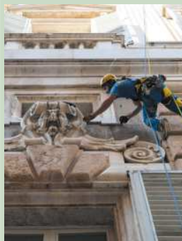
Lavori completati al 96%
