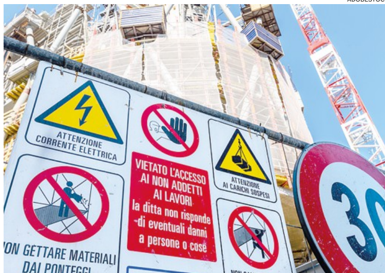
Il cantiere. Prevedeva la realizzazione di un grattaciolo da 200 appartamenti all'interno di un cortile
