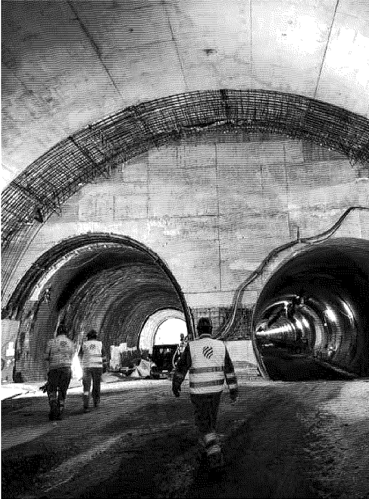
Lavori in corso. Il Terzo valico è uno dei cantieri che presentano criticità e ritardi
