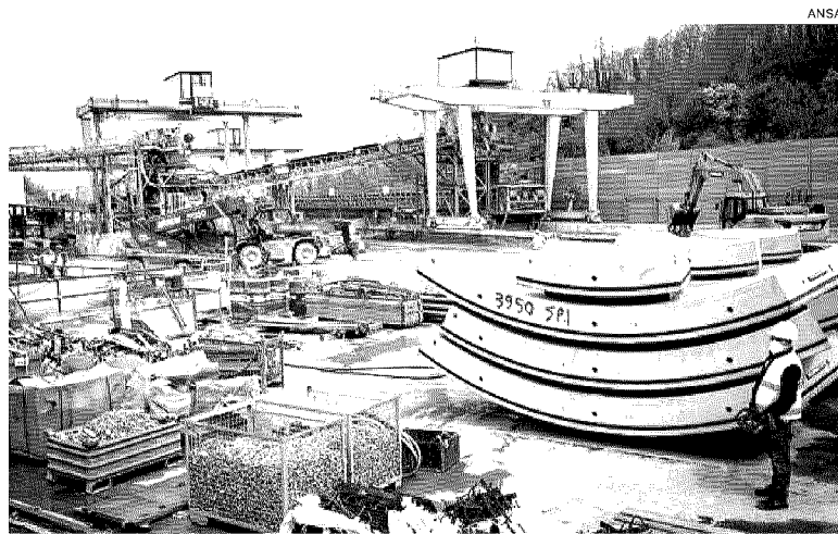
Cantieri Pnrr. I lavori per il terzo valico ferroviario tra Piemonte e Liguria
