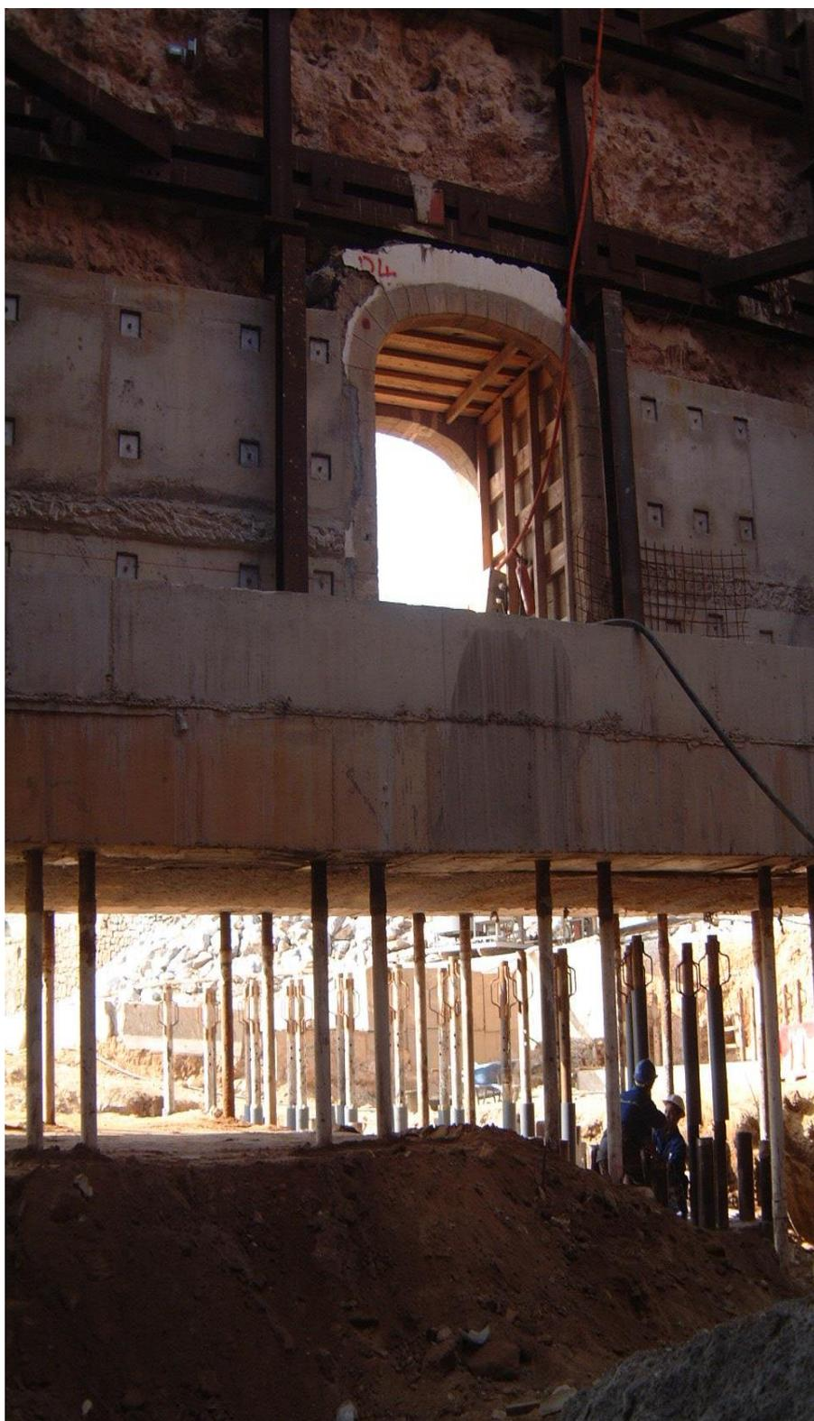
Si è quindi potuto procedere allo scavo sotto l'edificio dopo aver realizzato, come detto, il solettone di sostegno della costruzione storica con funzione anche di copertura della galleria artificiale, avendo precedentemente realizzato tre file di micropali (due ai bordi e una centrale) per il sostegno del solettone stesso (e quindi dell'edificio) e una vasca di jet grouting per poter scavare in presenza della falda.
