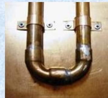
**raccordi misti** giunzione tubo di **rame** - tubo di **acciaio** ed anche per il collegamento di rubinetti, di raccordi, ecc. conformi alla UNI EN 1254-4
