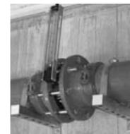
Esempi di differenti tipologie d'asametri installati su tubazioni 6" - DN 150
