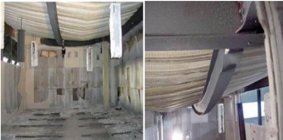
Figura 3 - Effetto catenaria di travi in acciaio soggetta ad incendio
