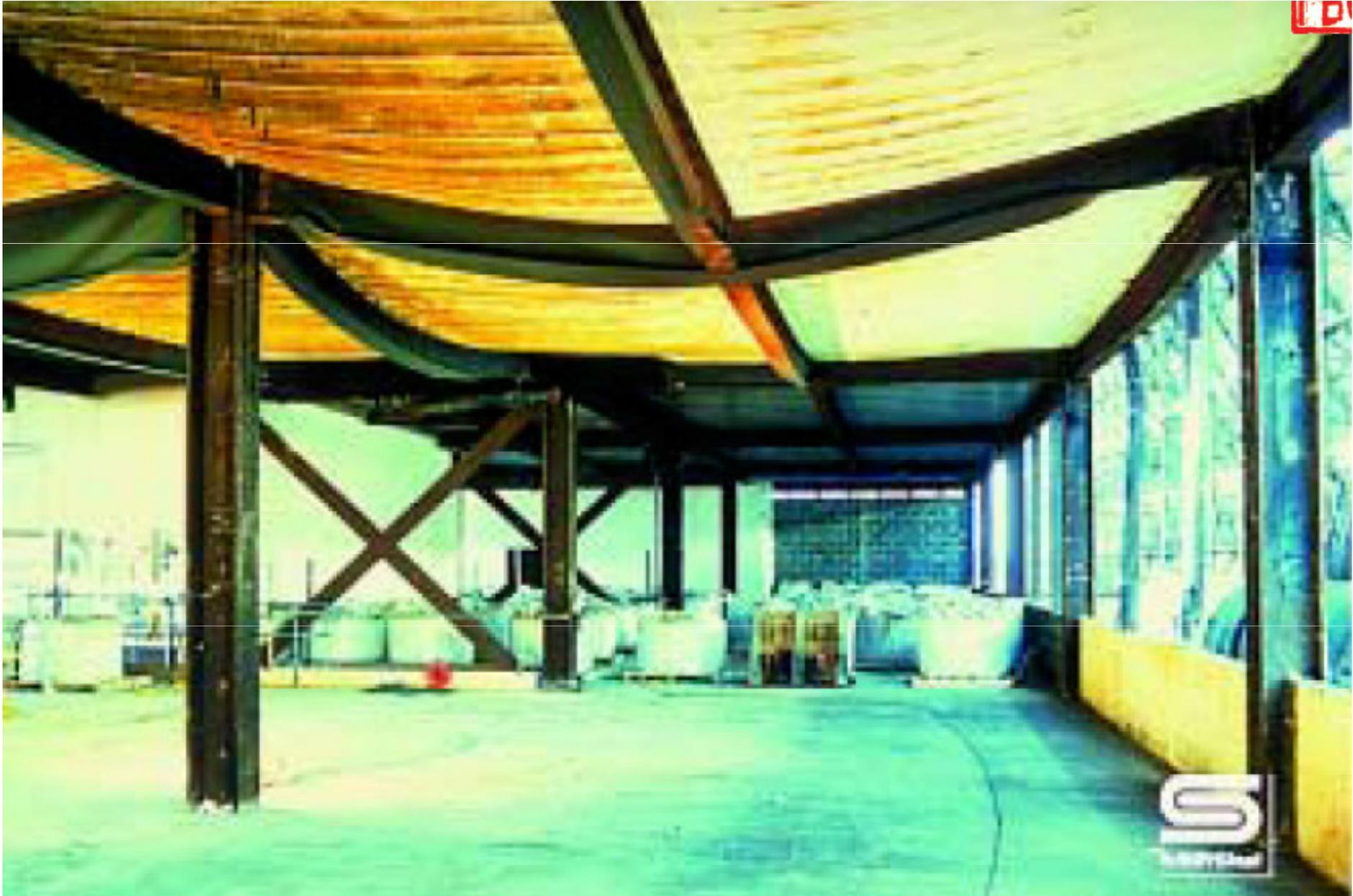
**Effetto delle coazioni in strutture iperstatiche, si consideri che all'aumento delle temperature diminuiscono i moduli elastici E e G che influenzano direttamente le coazioni.**
